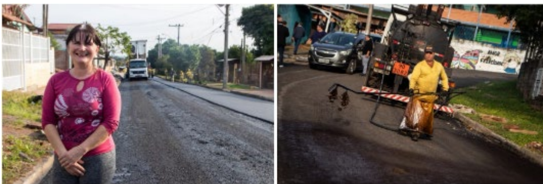
Imagem 1 – Vistoria da obra de pavimentação do Programa Caminhos da Escola
