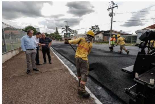
Imagem 2 - Vistoria da obra de pavimentação do Programa Caminhos da Escola
